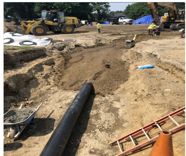
Backfilling Effluent Pipe Trench
