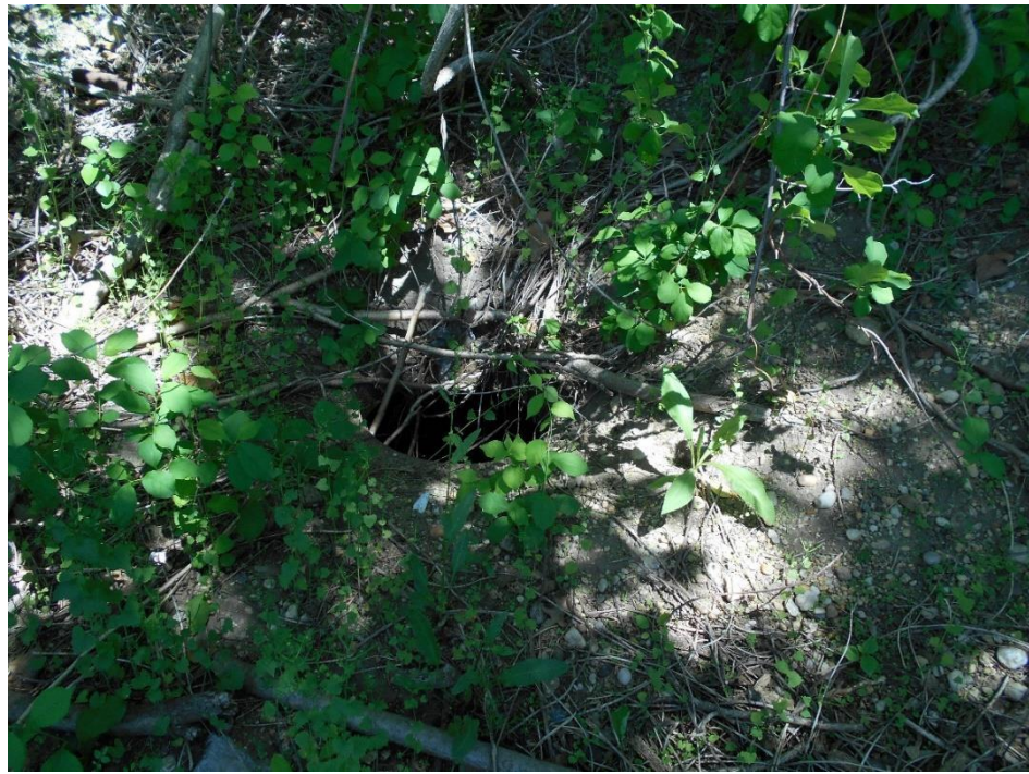
Photo 22 Site 1- : Cesspool without lid
