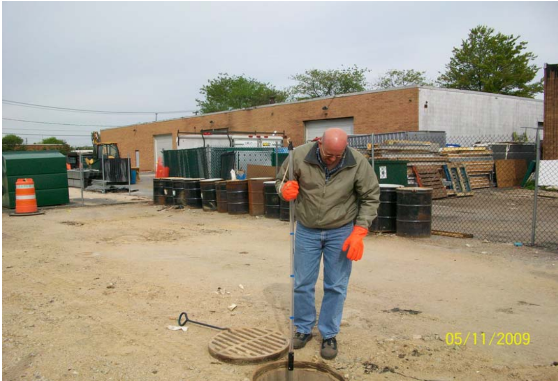
100_00584.jpg - Kevin Oldham (SCDPW) checking CP-7.
