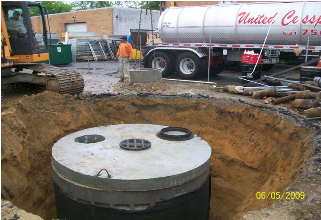
100_0764.jpg - PDS-11, 50 Dale St., installed
