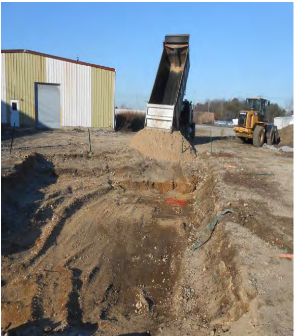
1. Unloading Clean Fill
