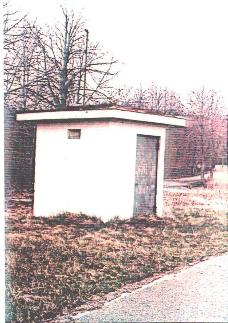
Sewage Pump House (Bldg. #MAF-30).
