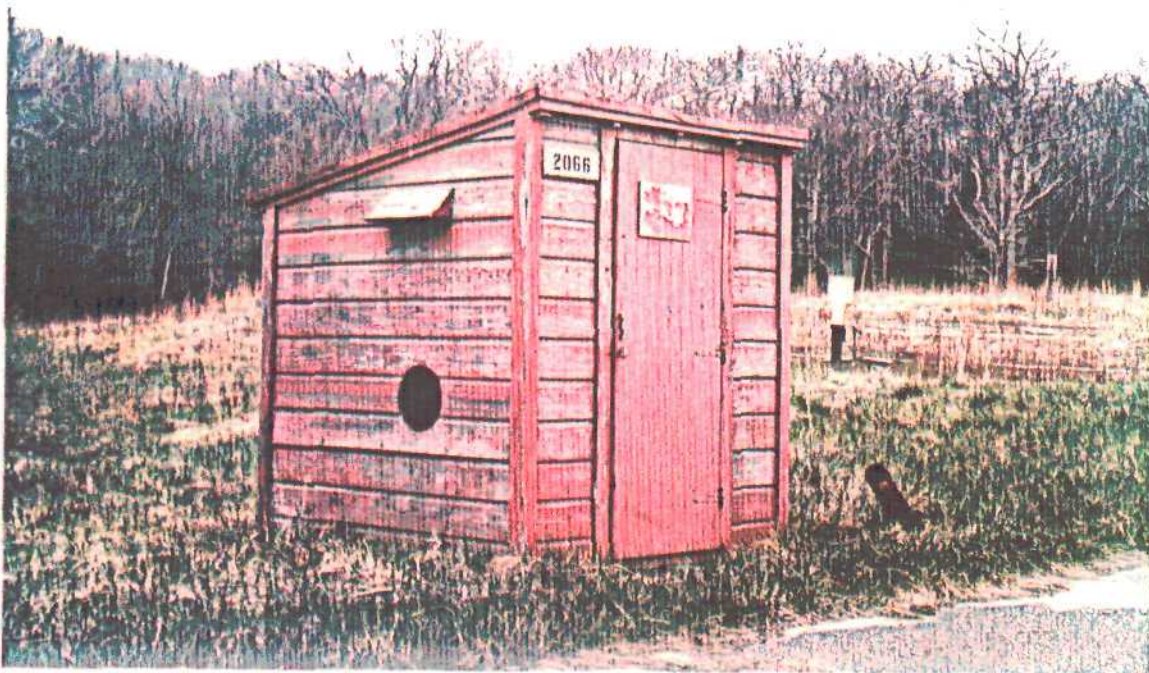
Hose house (Bldg. #2066).
