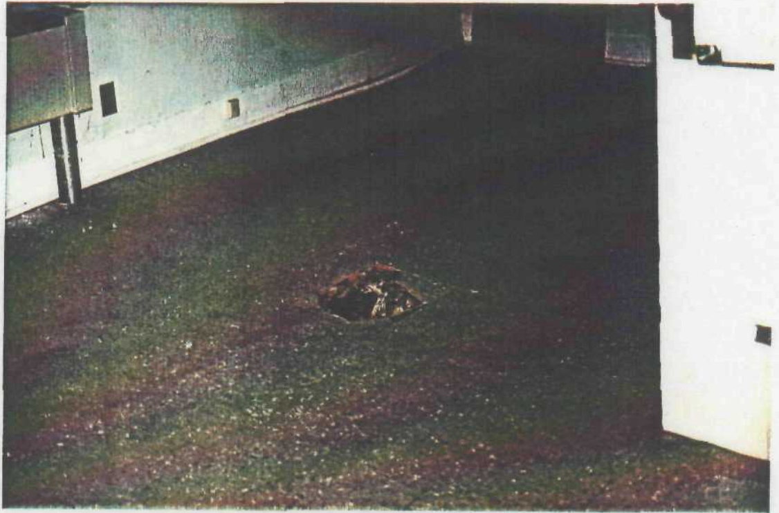
Sunken, damaged floor, bldg. #P-7.
