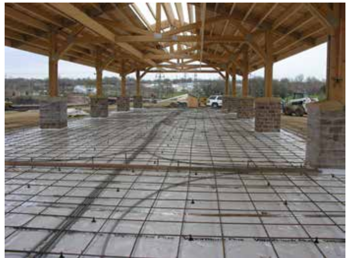
Under-Slab Vapor/Gas Retarder
