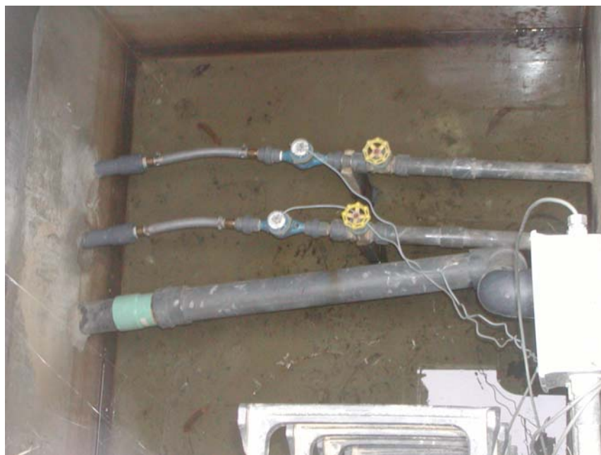
Effluent meter pit
