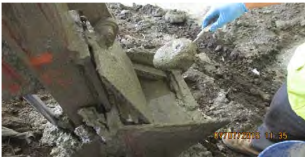
07 07 16 Taylor On Site
