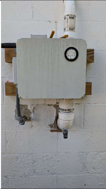
SSDS fan #1 repaired
