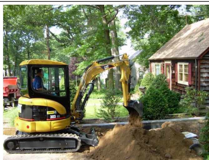
Excavadoras como esta van a ser usadas en el proyecto siempre que exista espacio para ello.
