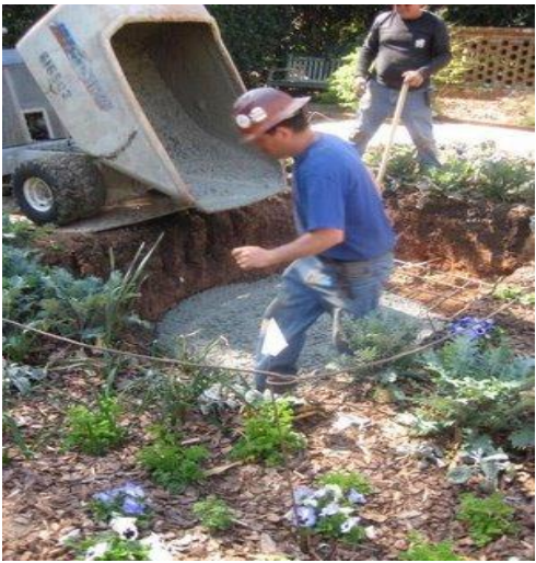
Carretillas motorizadas como esta se usaran para transportar suelos.
