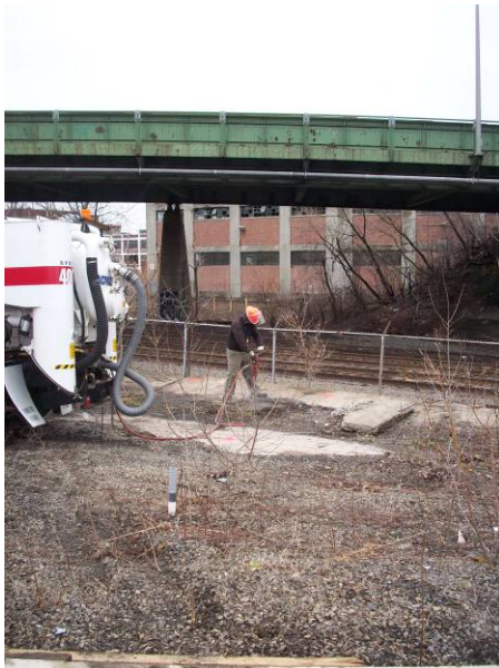
Jack Hammering IW-A3
