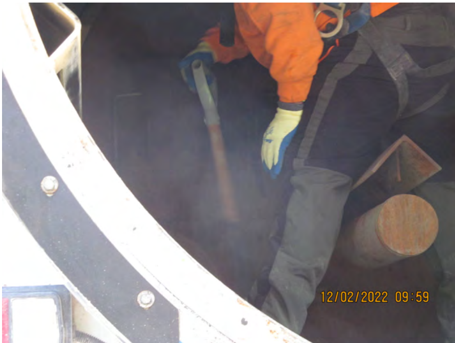
decon inside vactruck
