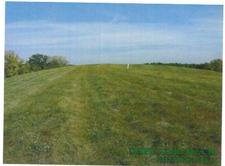
04 - Top of Landfill.jpg
