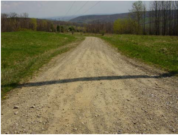
Access to Clark Rd..JPG
