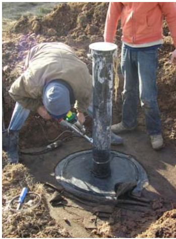
Z-02 Thermal Welding.JPG
