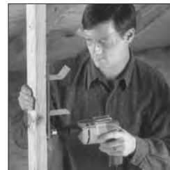
Fixer le support de montage (MB).
