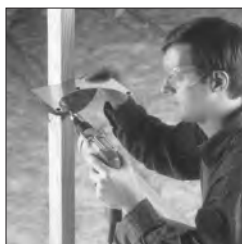
Fixer le support de montage (NB)
