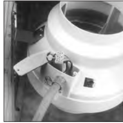
Câblage serré de liquide - vue de dessus (pour des installations extérieures)
