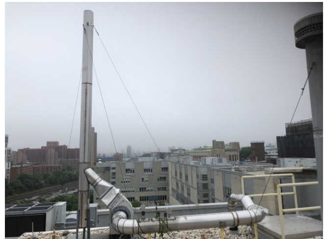
Photo 4: View of SSDS fan unit EF-1.
