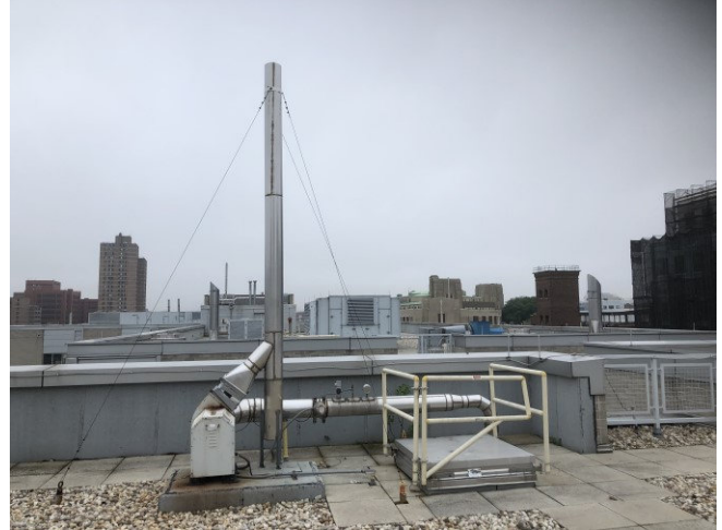
Photo 8: View of SSDS fan unit EF-6.
