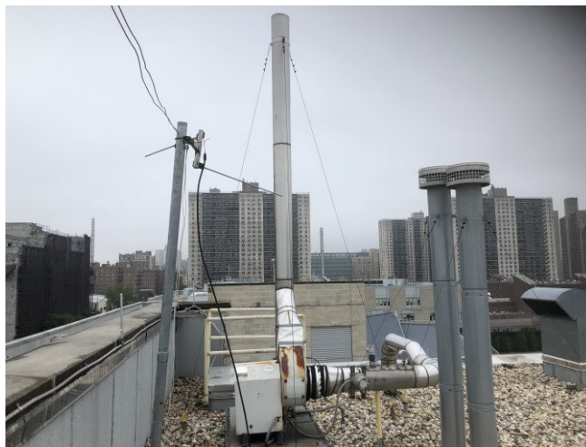
Photo 11: View of SSDS fan unit EF-4.
