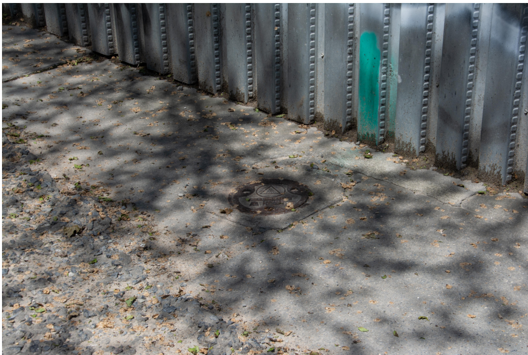
MW-8 Close Up
