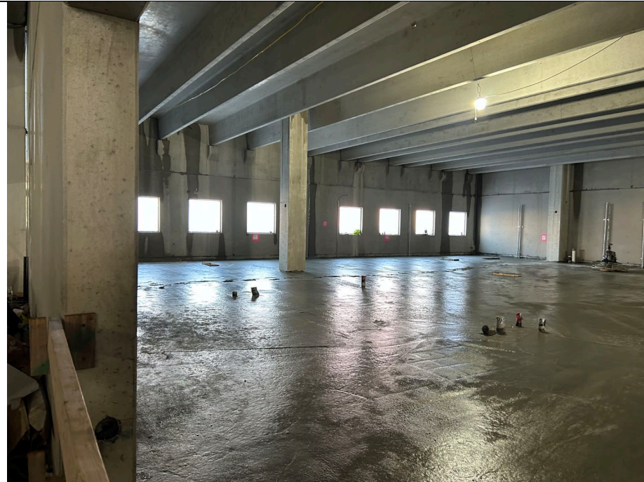
Photo 3: Concrete pour in grid A4.
