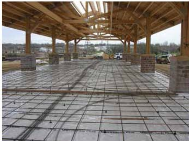
Under-Slab Vapor/Gas Retarder
