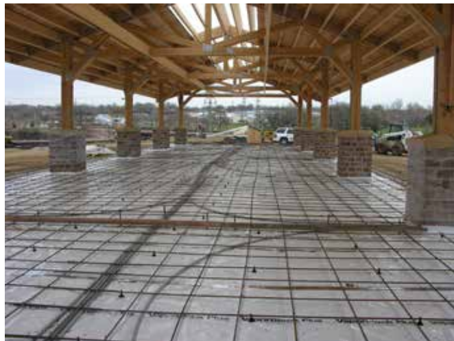
Under-Slab Vapor/Gas Retarder
