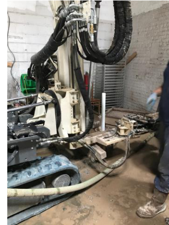
Photo 2: Installation of MW-03(D)
