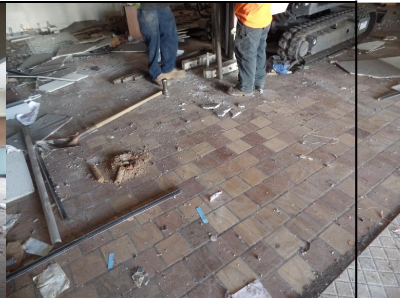
Installing SB-2 / MW-2
