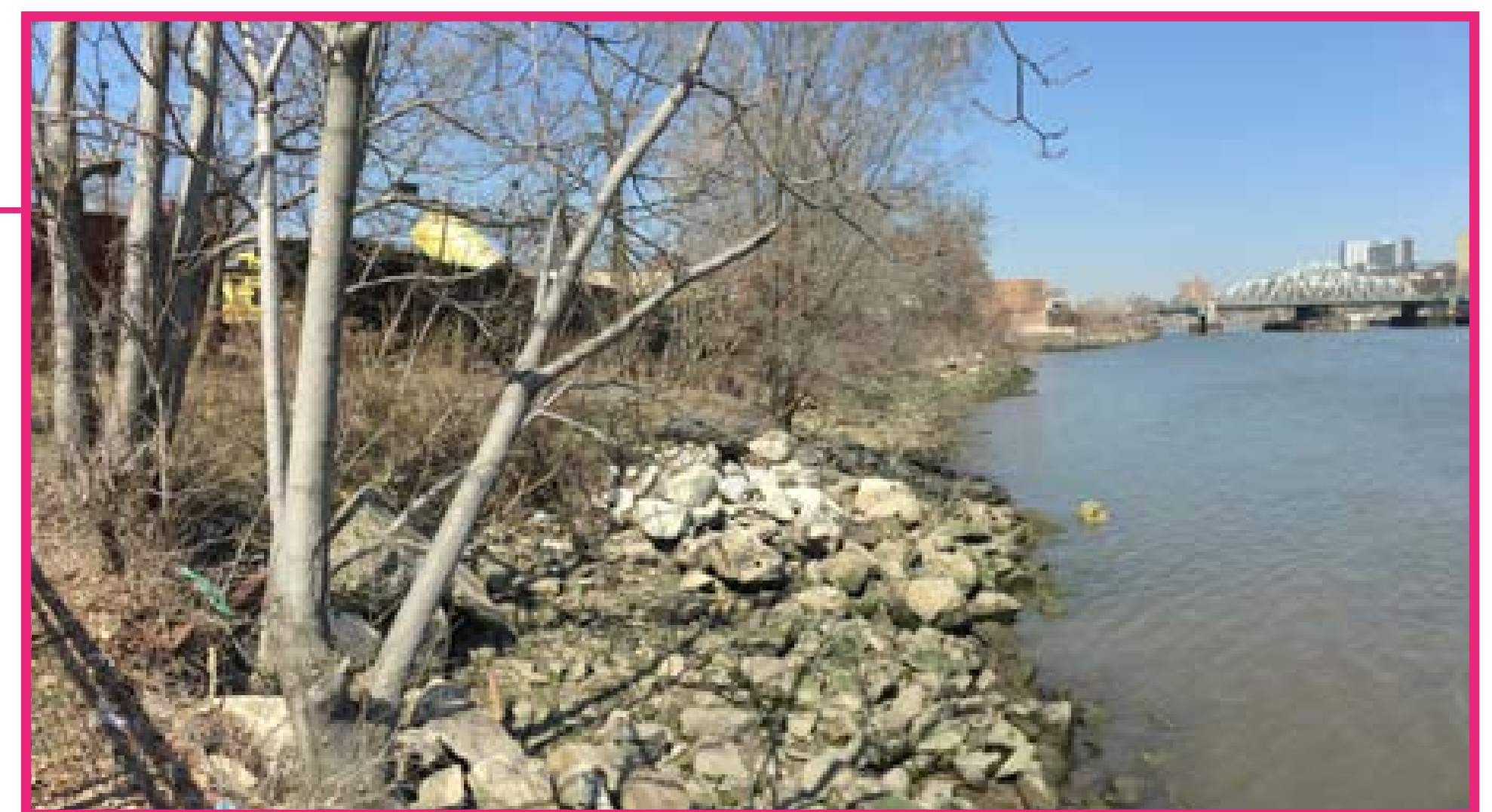
Existing waterfront conditions along Harlem River Condiciones existentes a lo largo de la Línea Costera del Río Harlem
