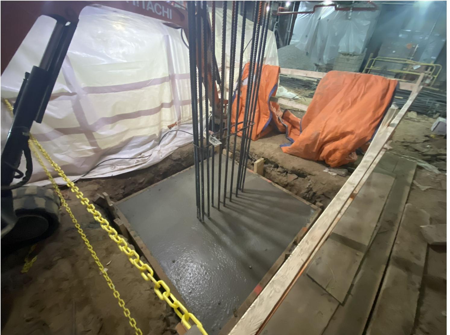
Photo 2: Concrete pour at PC-4
