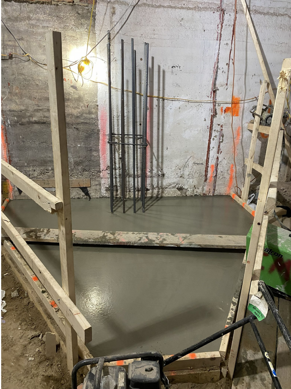
Photo 3: Concrete pour at PC-4ANE
