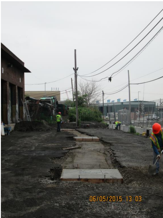
Pour Well Vault Pads S-4E, 4D, 4C and 4B
