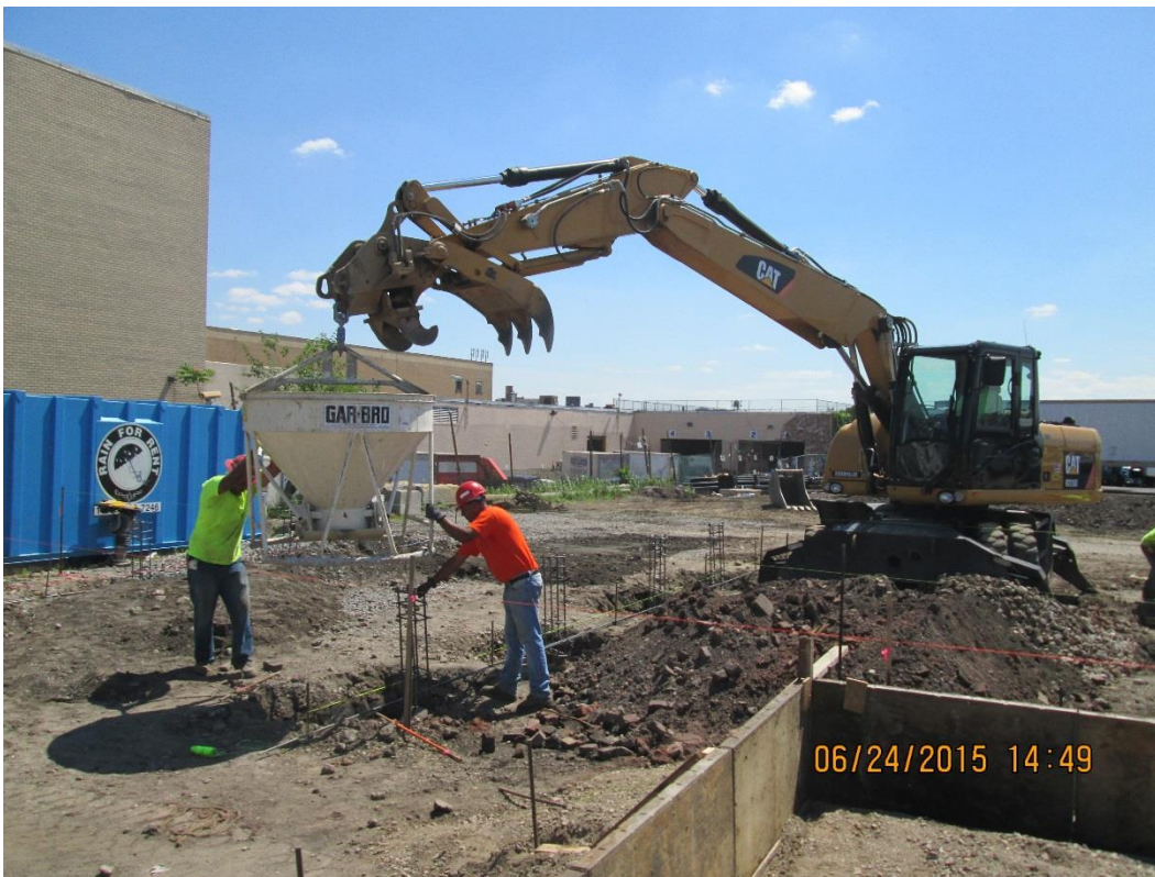
Pour equipment trailer pier footings
