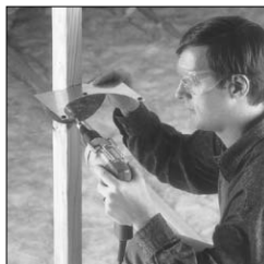
Fixer le support de montage (NB)
