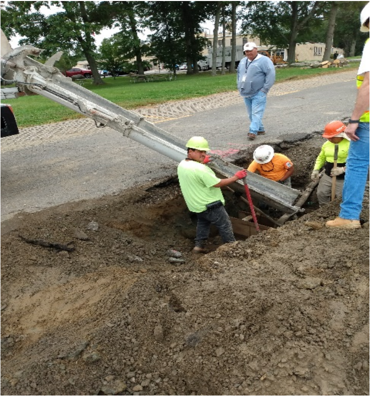
Photo 6 – Pouring seep collar
