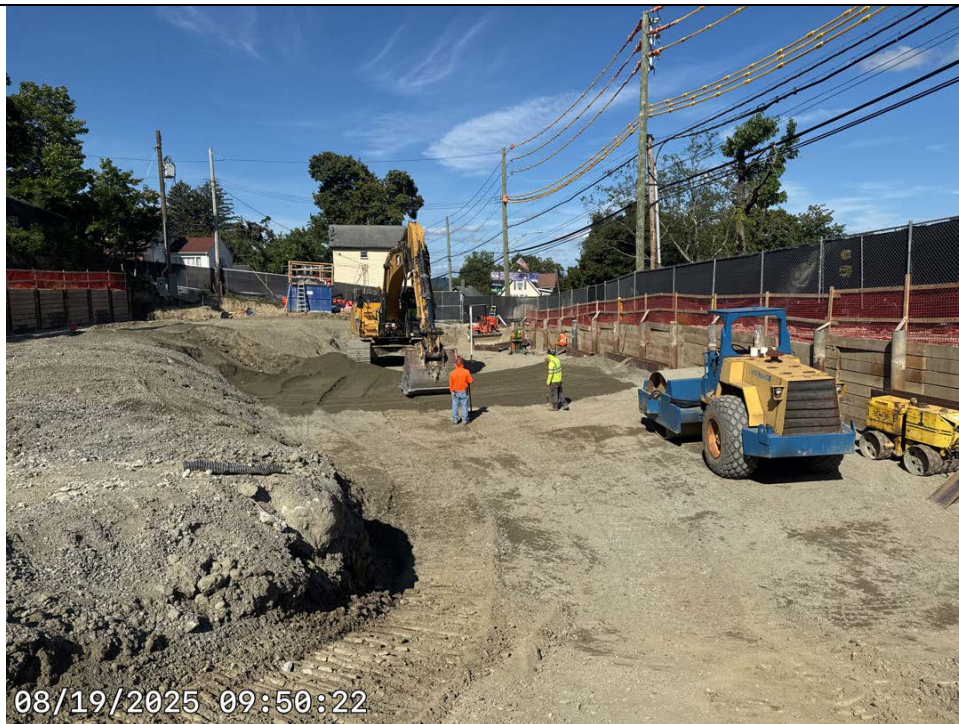
Photo 2: Structural fill import
