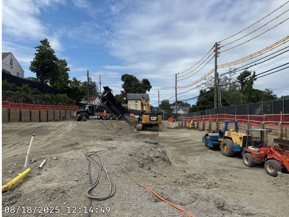
Photo 1: Structural fill import
