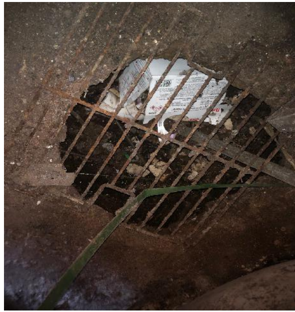
Fig. 4 : Floor drain basement
