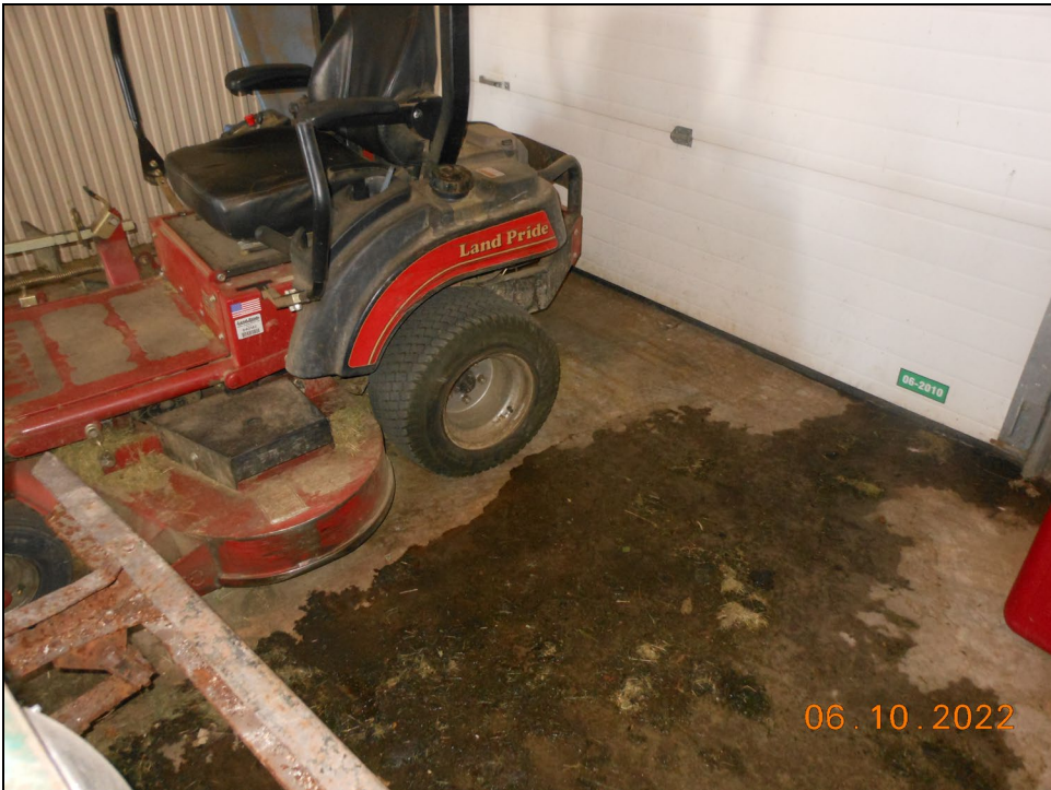
5.) PAOC 6b Concrete Floor Slab(s)
