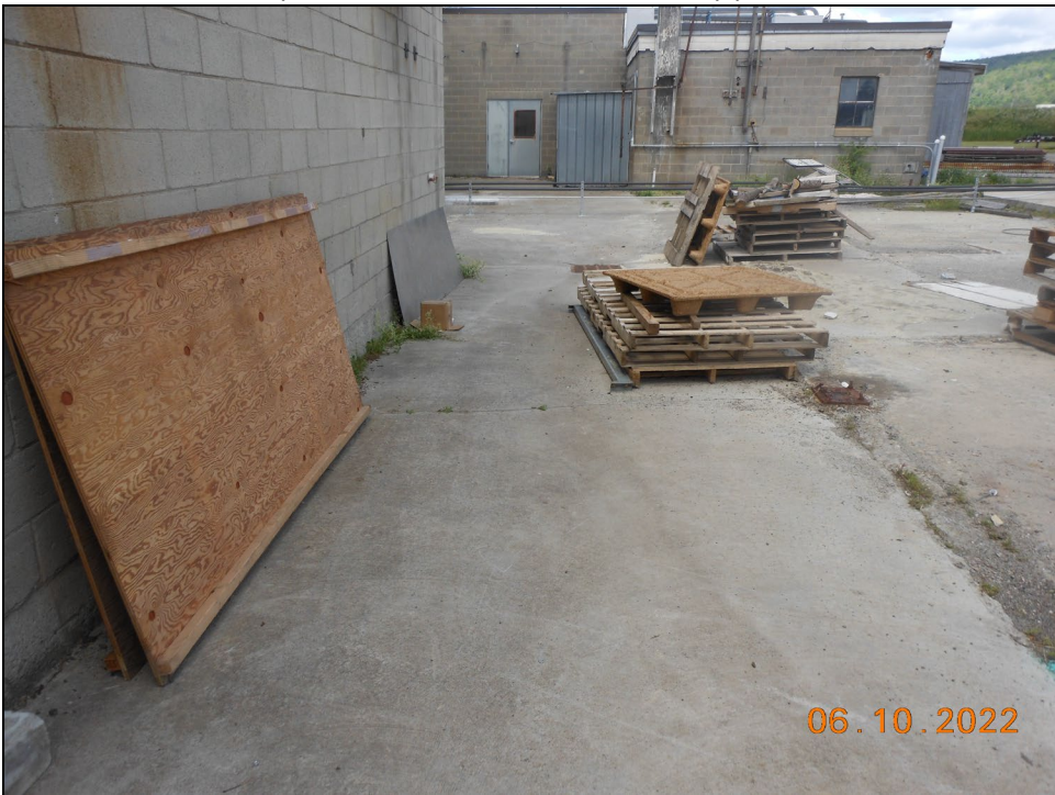
7.) PAOC 8 Concrete Slab
