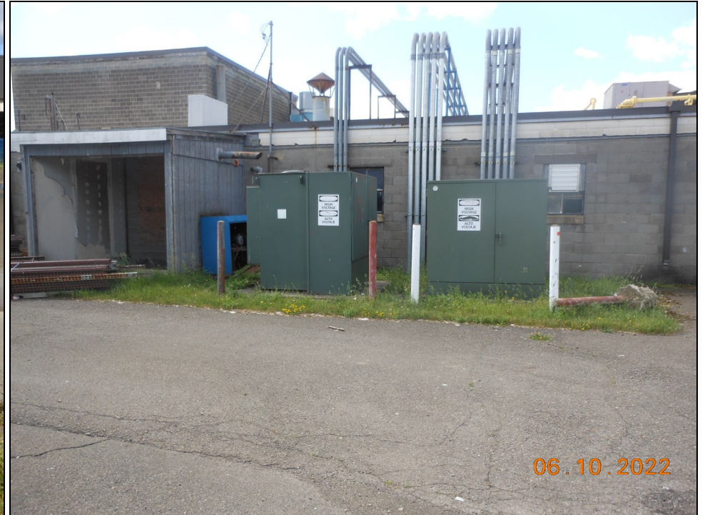
4.) PAOC 6b Concrete Slab(s)
