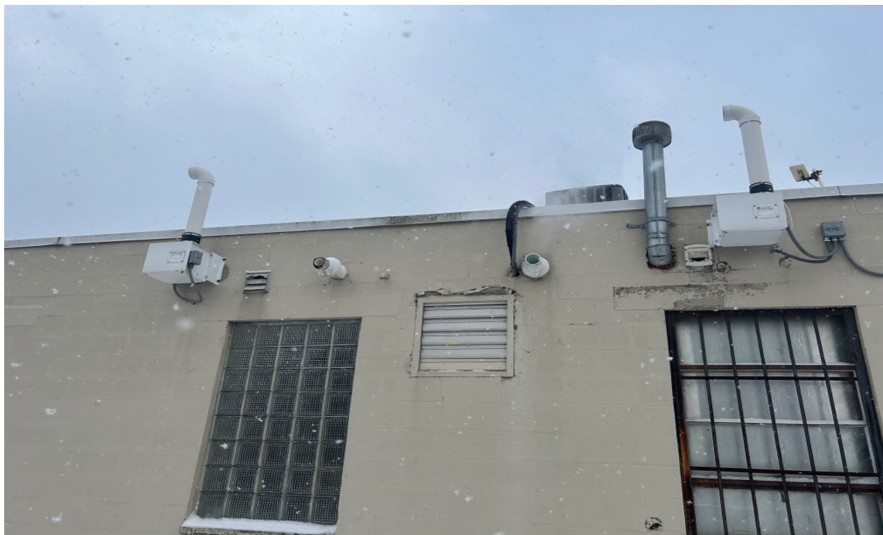
SSDS Discharge and Fan
