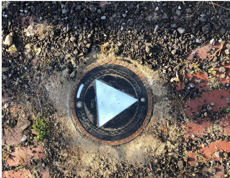
New curb box lid for IW-25.
