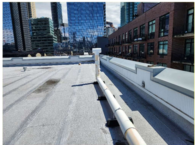
Effluent Stack on Roof
